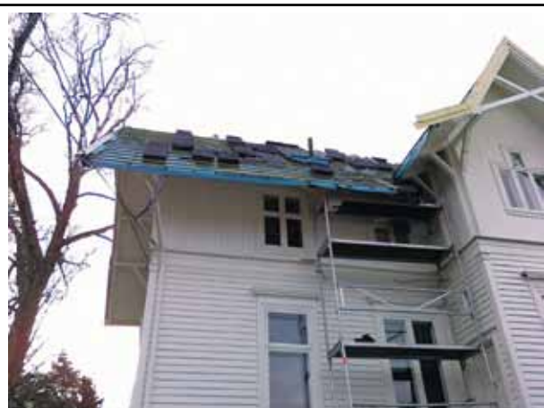
«Et eksempel på godt sikringarbeid ved takarbeid.»
