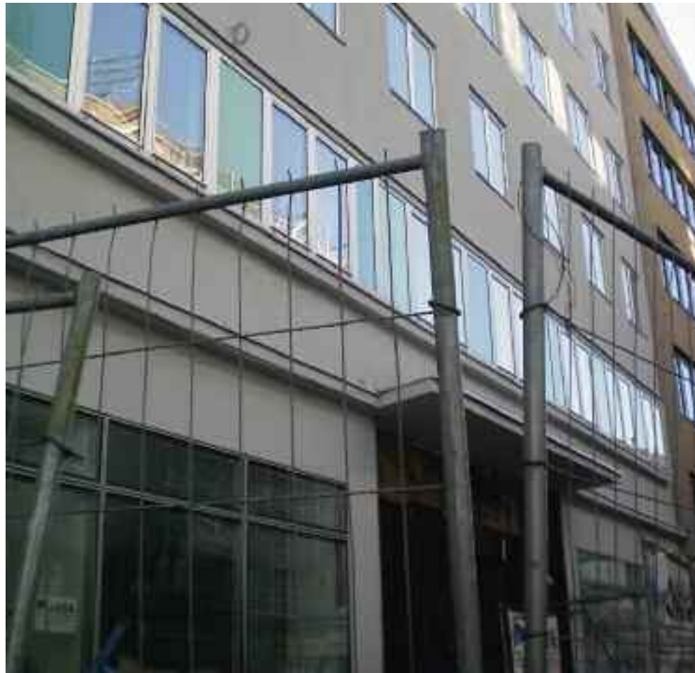
Prosjektet var å bygge prestisjehotell for Petter Stordalen og Choice-kjeden, men nå har byggearbeidene stått stille i lang tid.
